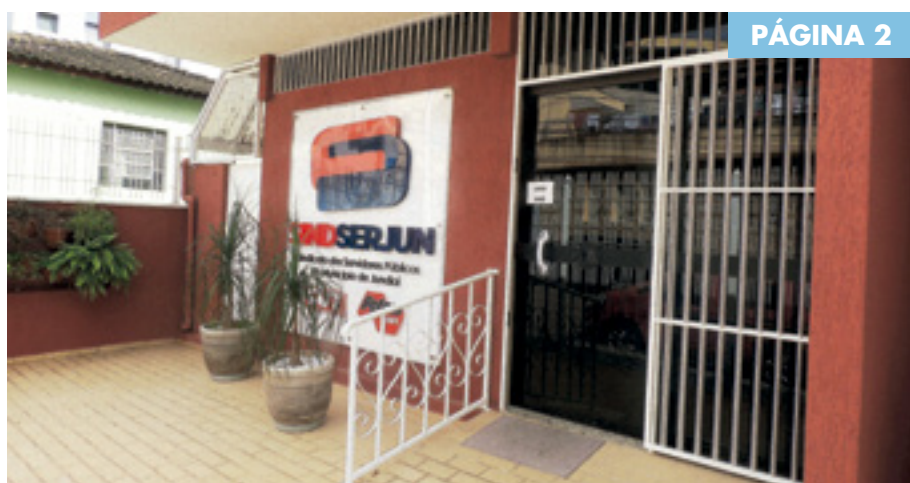
Reforma da sede do Sindicato
